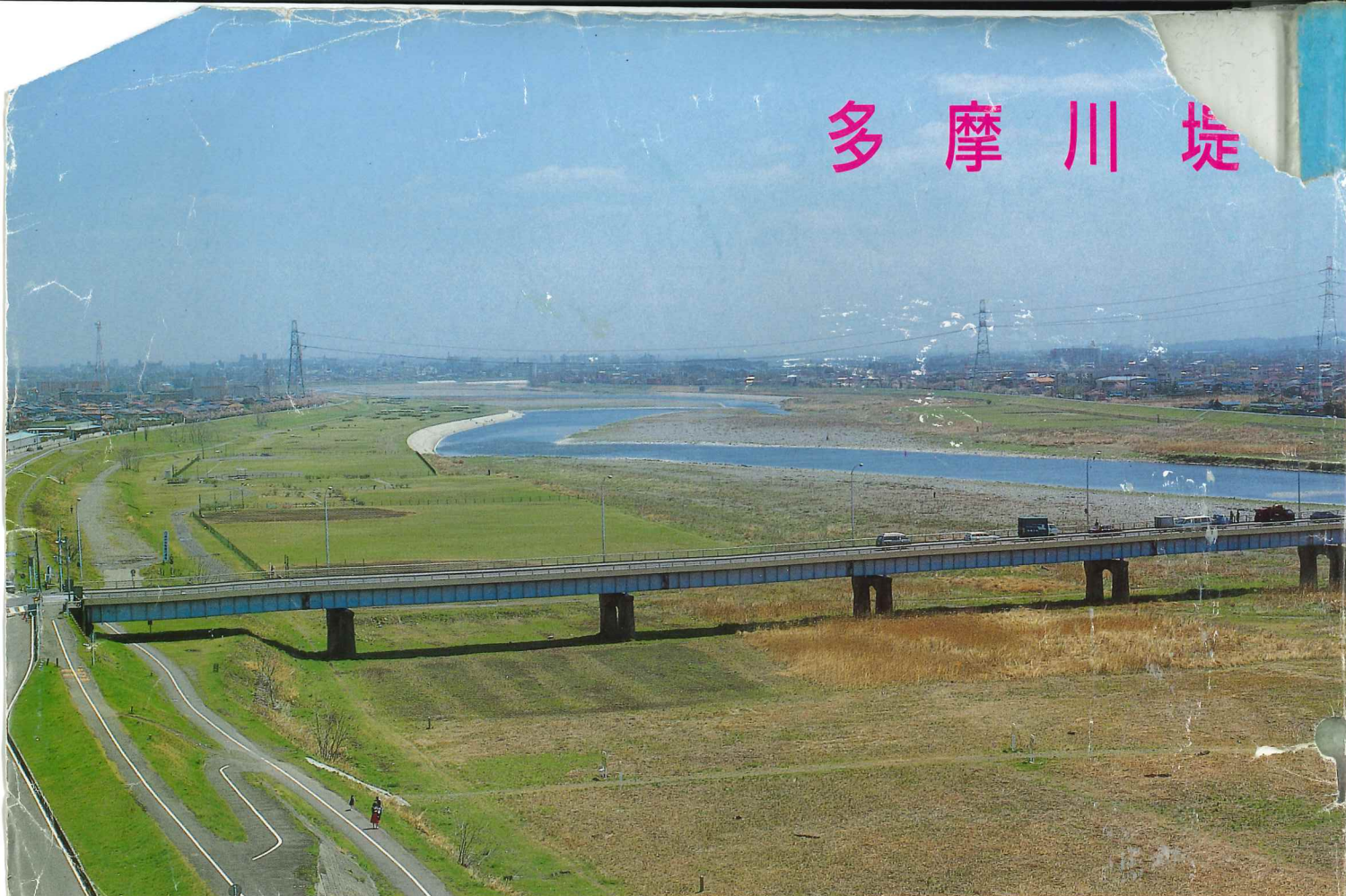
2号棟屋上よりは是政橋、多摩川
