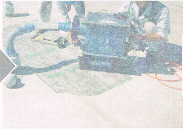
ライニング工事施工(中)
