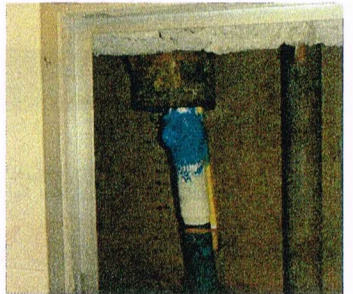
③ピットから管内へ
