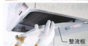
**01** グリスフィルターを外します(整流板があるタイプは先ず整流板を外します)。
