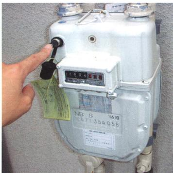
3分経過後も、ガスが止まったままで表示ランプが点滅している場合は、ガス機器の止め忘れやガス漏れが考えられますので、もう一度ガス栓の閉め忘れやガス機器の止め忘れがないかご確認ください。ガス栓の閉め忘れがあった場合は、そのガス栓を閉めてから、もう一度復帰の手順に従って操作してください。
