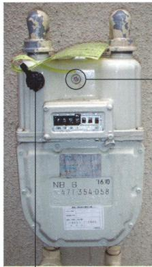
赤い表示ランプが点滅していればガスが遮断されています。マイコンメーターのこの表示ランプが赤く点滅しているかどうかご確認ください。
