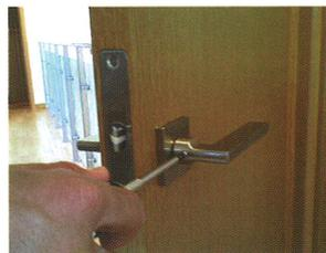
03 ドライバーで固定ネジを締め付けます。
