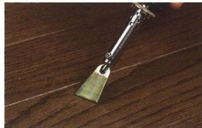
02 電熱補修コテを傾けて少しずつ溶かしながら手前に引き平らに仕上げます。
