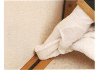
**04** レールに付着したゴミはシリコンスプレーを使って拭き取ってください。スプレーは直接吹き付けずウエスにつけてから行ってください。
