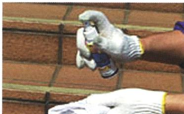
**01** 洗浄剤を布等に含ませ、洗浄対象部に塗布します。洗浄剤がエフロ（白華）と反応して炭酸ガスが発生します。
