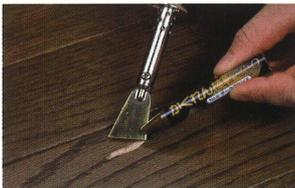
01 補修箇所の周囲に合った色のかくれん棒PROを選び電熱補修コテの上で溶かしキズの箇所だけに盛り上がるように流し込みます。
