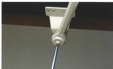
02 枠に付いているアームの付け根のネジをドライバーで締め付けます。これで指定した位置でドアが止まるようになります。
